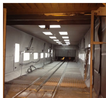
Mise à niveau des salles de grenaillage à air comprimé
