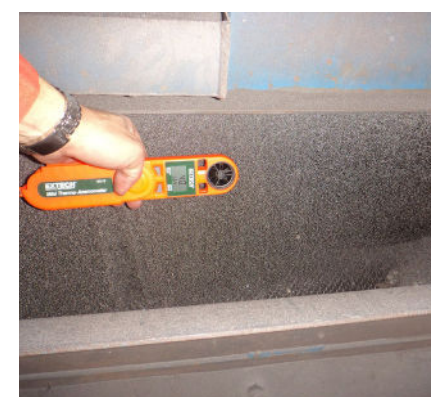
Optimisation du lavage à l'air
